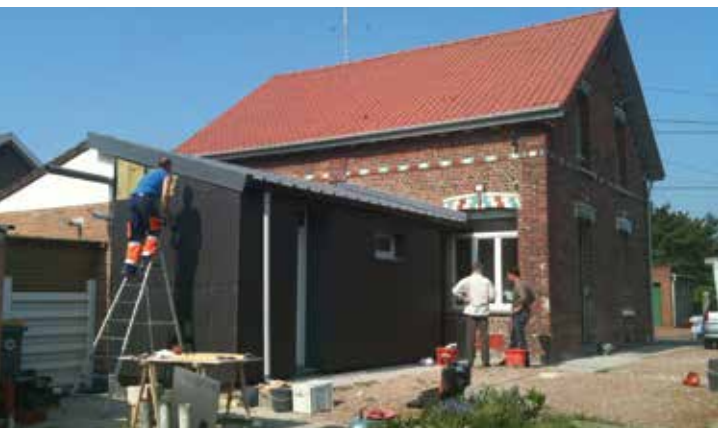
Isolation extérieure d'une extension.
