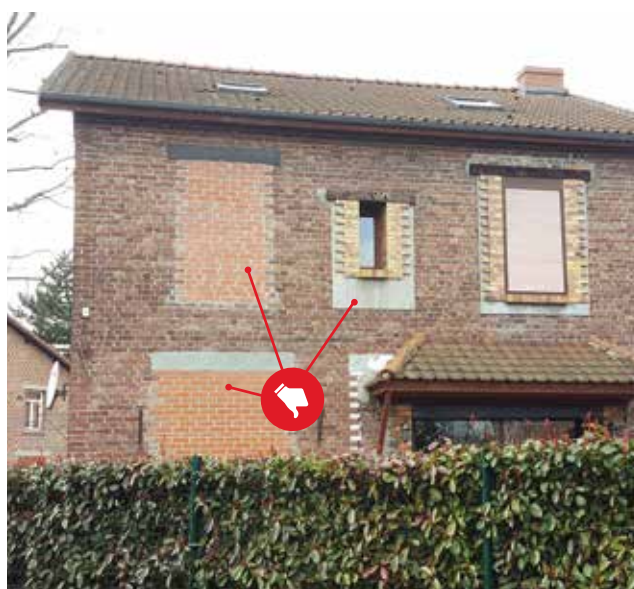
Modifications de baies.
